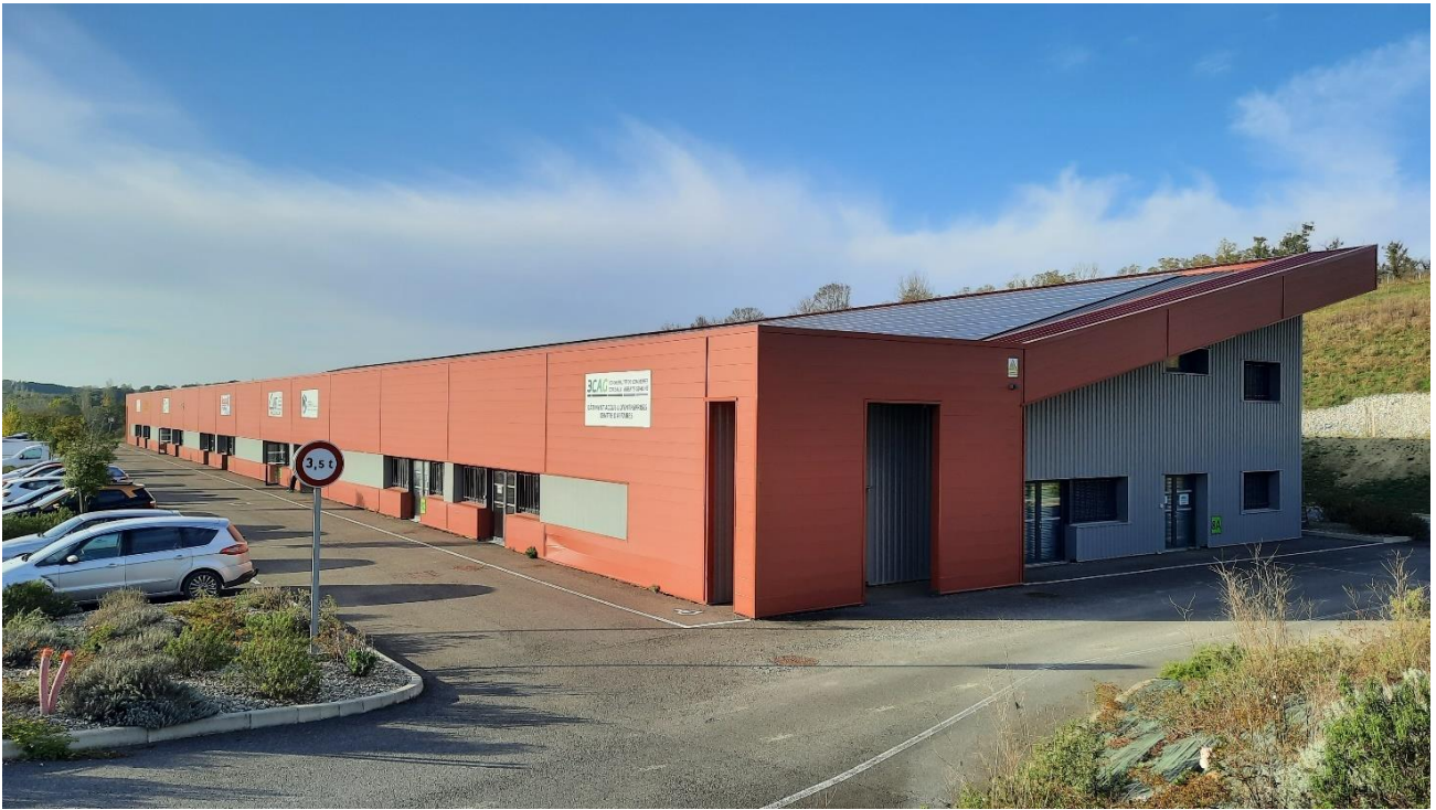
BATAC - Façade avant (entrée bureau)
