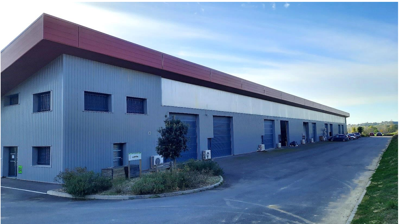
BATAC - Façade arrière (entrée atelier)
